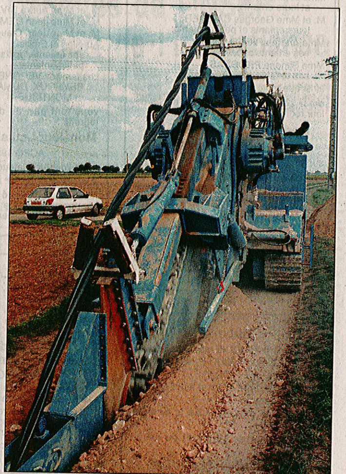
Avec le système Darlavoix, copié depuis avec plus ou moins de bonheur, on pose 400 m de câble par jour en réseau souterrain.
